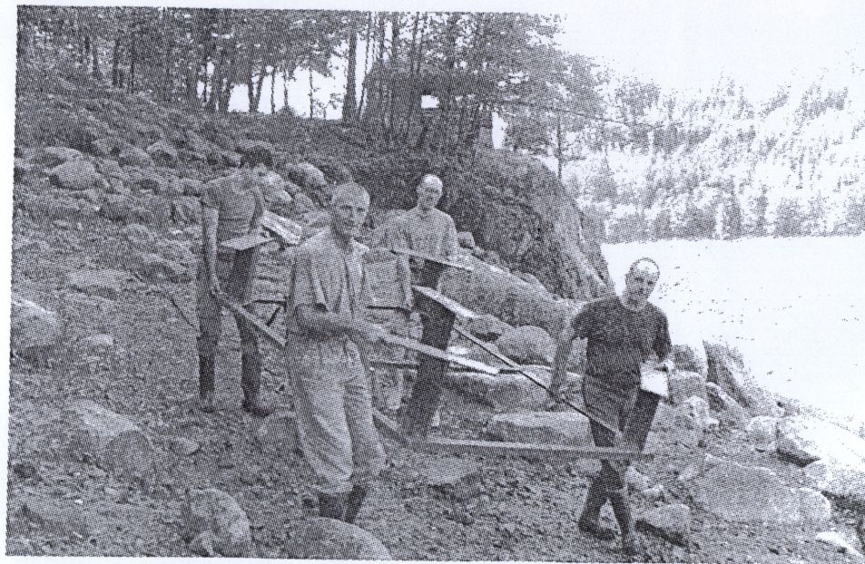
14. Mise en place d'une plateforme immergée au fond du lac de Kruth Wildenstein, par une équipe du T.P.M.
